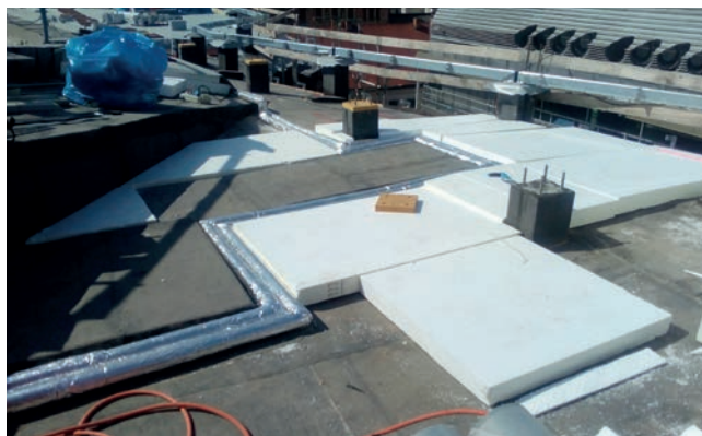
Složitá montáž tepelné izolace
