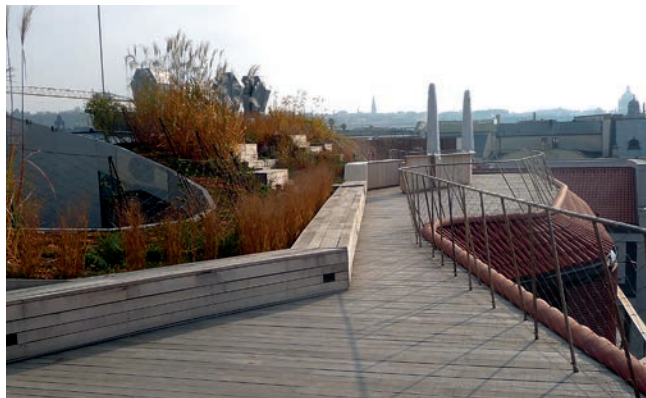
Terasa na druhé etapě budovy
